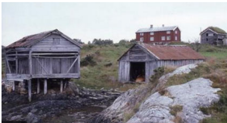
Figur 26 Bygningsmiljøet på Skaget
