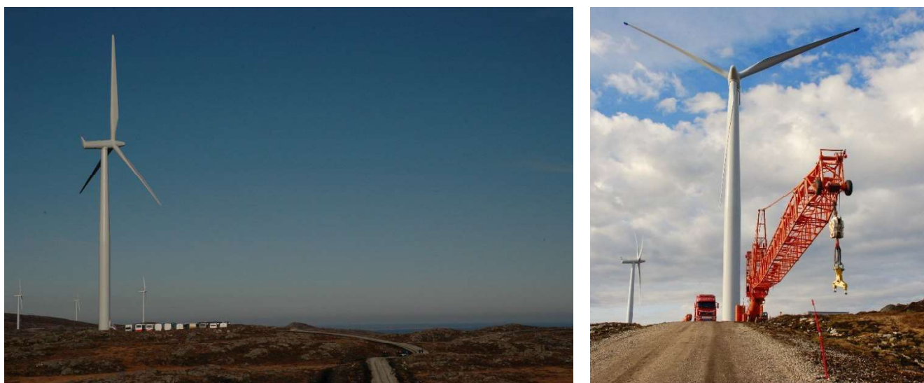
Figur 2-1: Bildet til venstre: fra åpningen av Hitra 1 vindkraftverk. Bildet til høyre: fra byggingen av Hitra 1.
