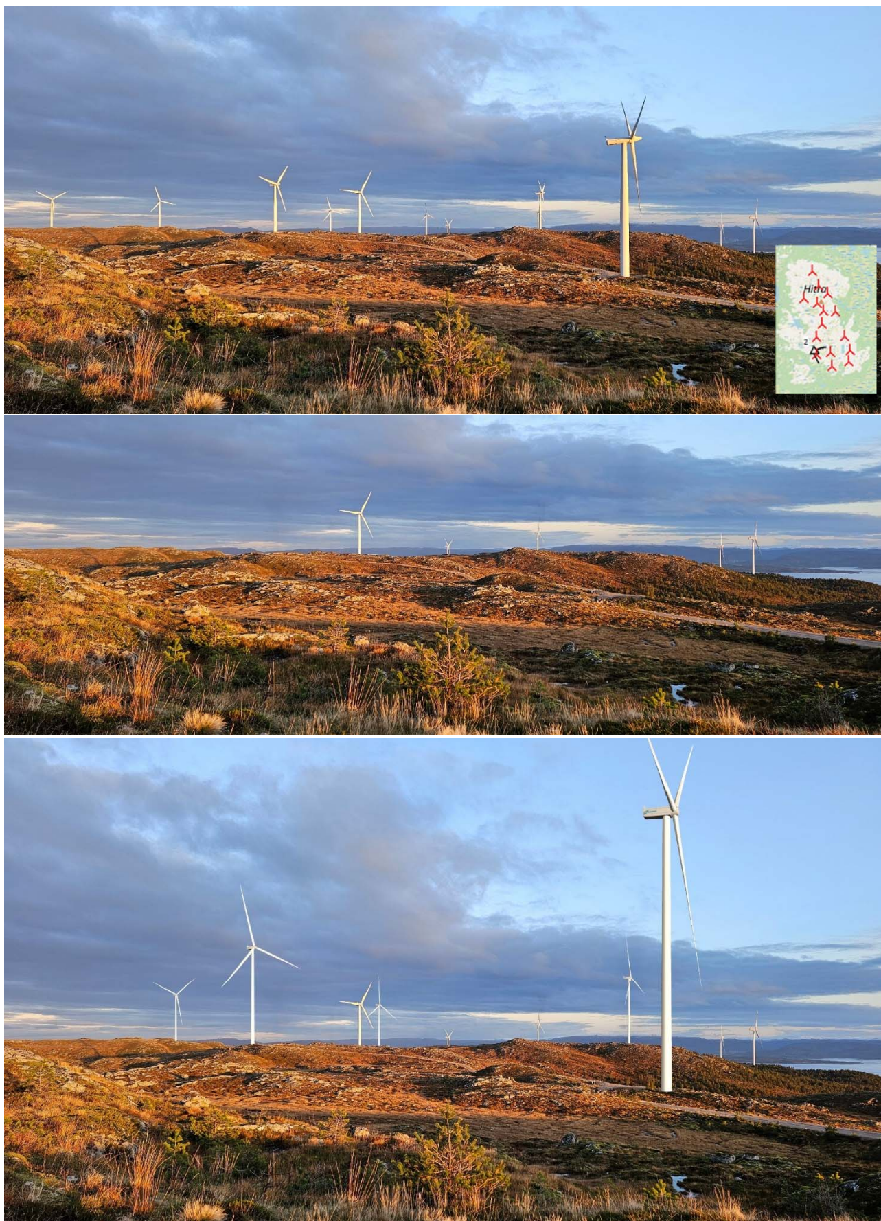
Figur 5-18: Hitra Vindkraftverk sett fra planområdet, ved VT9/VT10 mot sørøst (standpunkt 2 fra Figur 5-15). Eksisterende situasjon øverst, 0-alternativet, der Hitra 1 er sanert bort, i midten, og Nye Hitra 1 vindkraftverk nederst.
