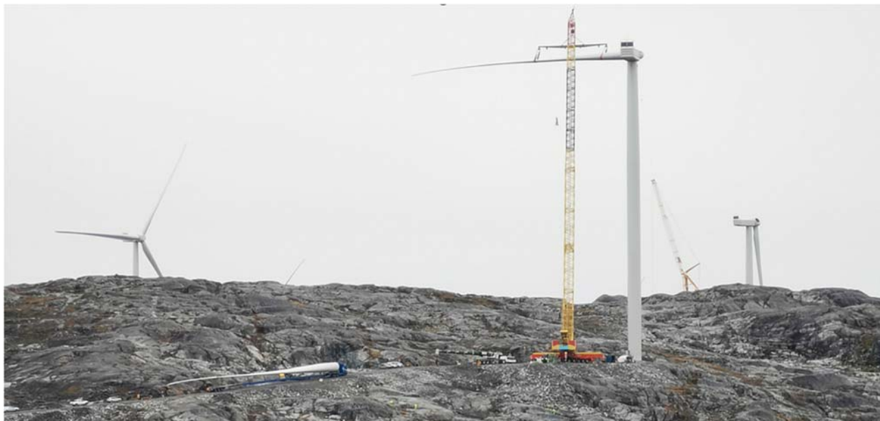
Figur 3-12: Bildet gir et inntrykk av dimensjoner på komponenter og kraner som skal benyttes. Her vises turbinblad levert direkte til montering. (Øyfjellet Vindkraftverk).
